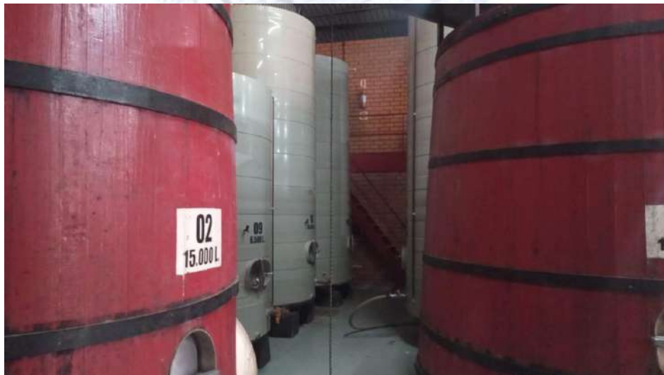
Tanques de Vinho
