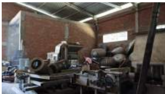
Vistas Galpão de Depósito
