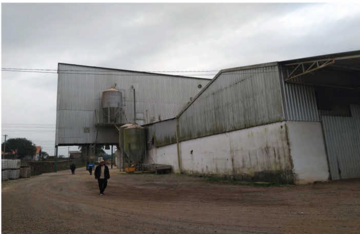
Vista lateral sul da Fábrica. Do lado esquerdo vemos a área de expedição a granel. A expedição a direita e mais alguns silos de insumos na lateral do prédio.
