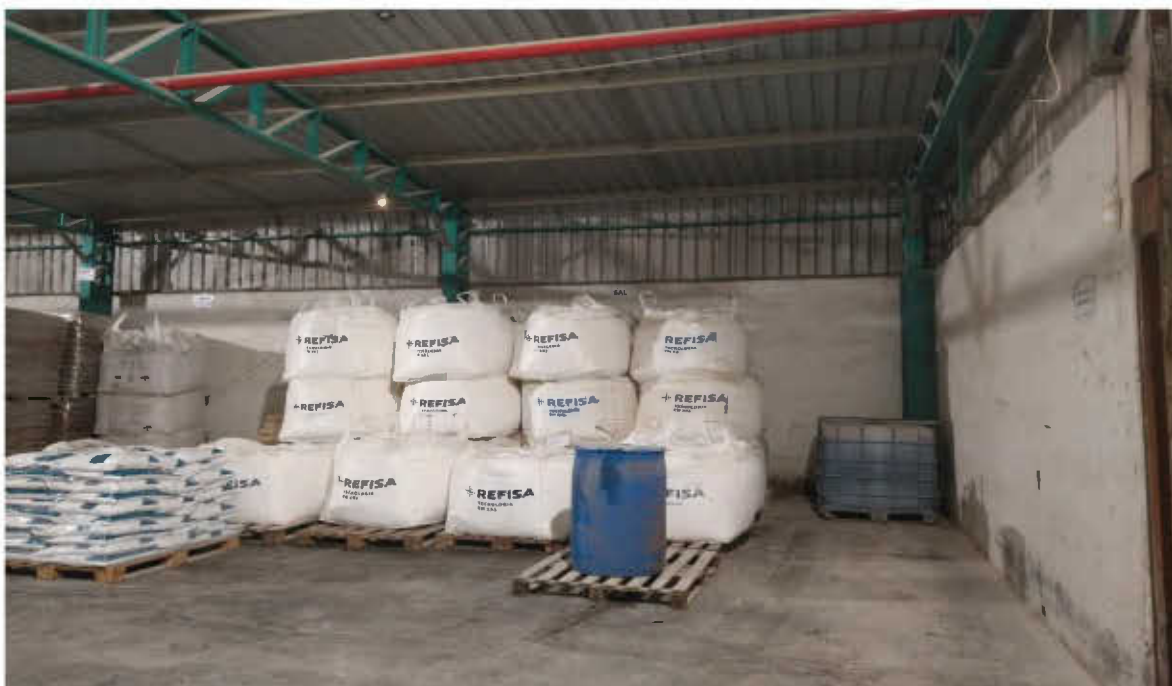
Mais uma vista da expedição de bags. Notamos aqui que o pavilhão é fechado externamente em alvenaria rebocada.
