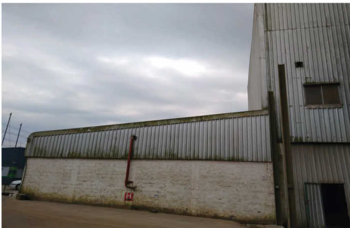
Vista lateral da área de expedição de bags. No canto da foto a esquerda vemos o canto do escritório.
