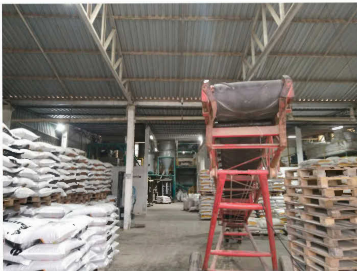
Foto realizada no portão da expedição, tendo uma visão geral da Fábrica ao fundo.
