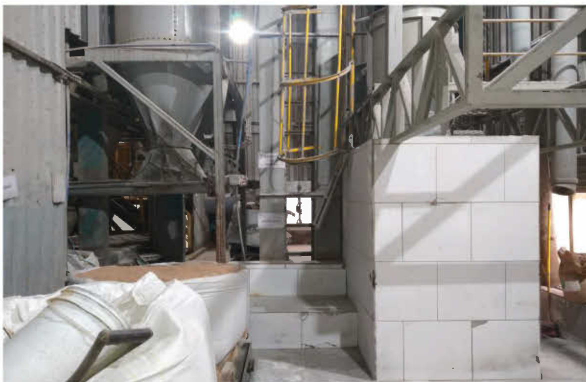
Foto realizada no Mezanino de Separação de Grãos, onde vemos as paredes revestidas com cerâmica e laje de piso de concreto armado.
