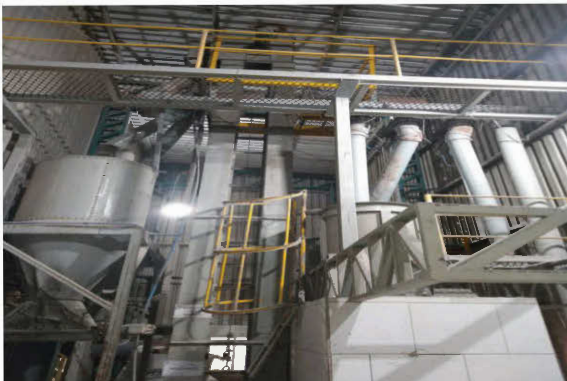
Vista mais ampla da sala de separação de grãos, com fechamento em estrutura metálica.
