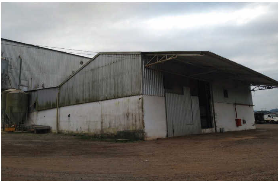
Vista externa do canto sul leste da estocagem e expedição do pavilhão da Fábrica.
