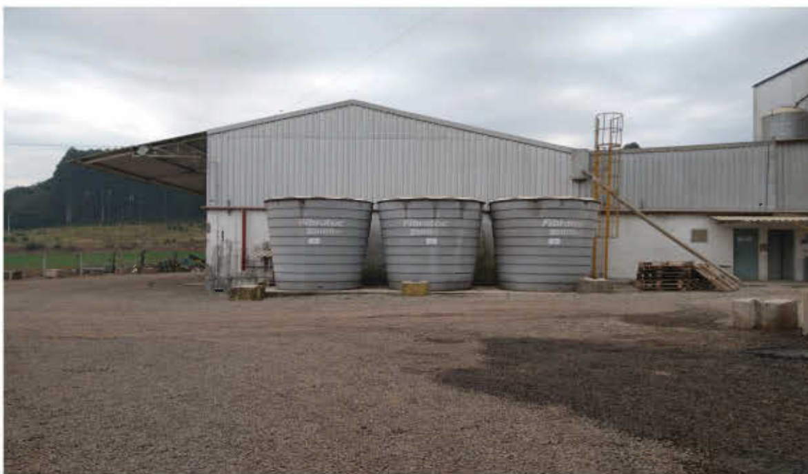
Aqui vemos os reservatórios de água, em primeiro plano, atrás temos o pavilhão da Fábrica com a varanda da expedição a esquerda. A direita temos a entrada lateral da Fábrica e o acesso a moega. Vemos que o pavilhão tem fechamento parcial em alvenaria rebocada e os oitões com fechamento em telhas metálicas.
