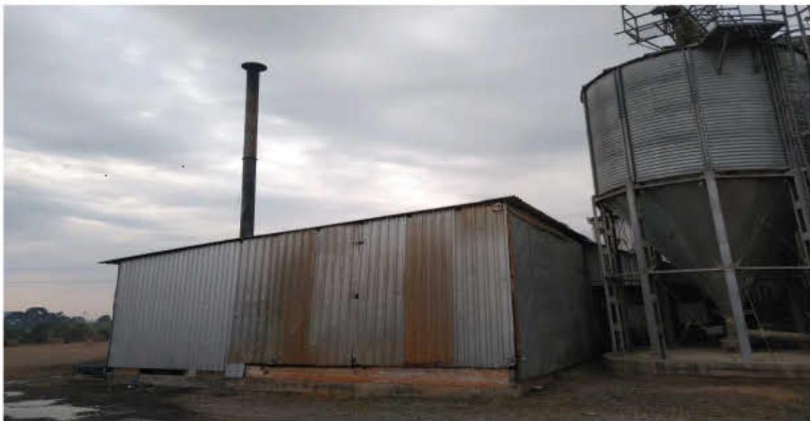
Nesta foto vemos o pavilhão da caldeira e os silos elevados a direita.
