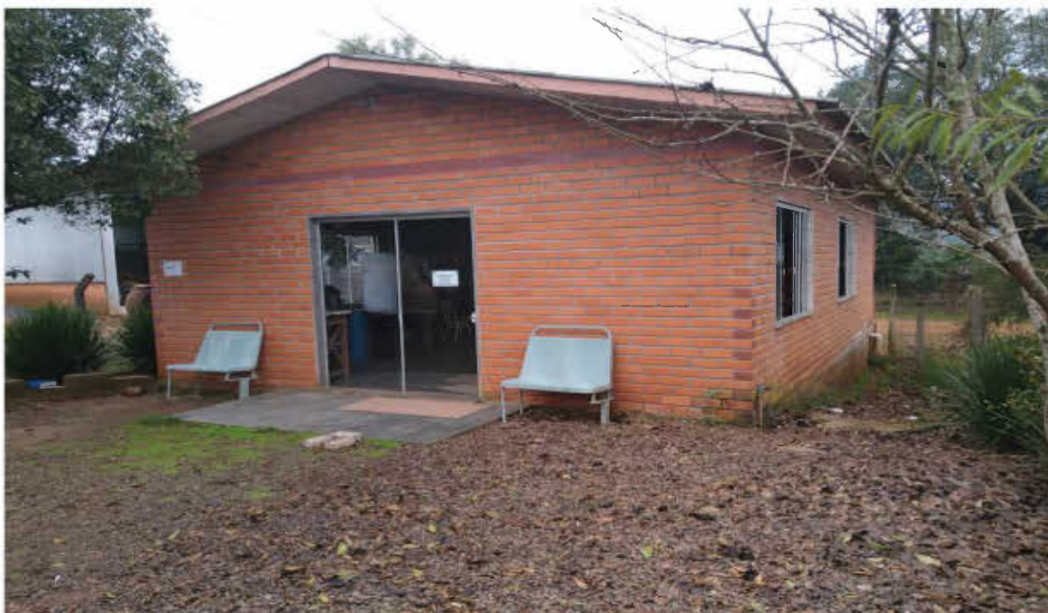
Prédio do Refeitório
