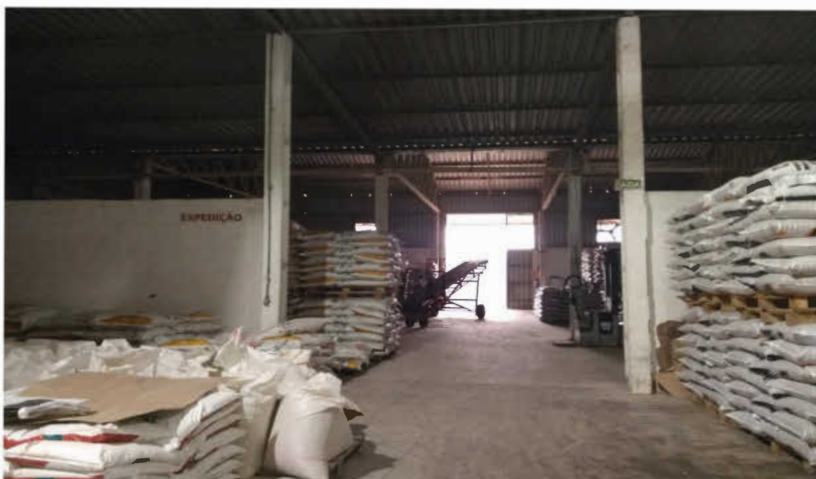
Vista da estocagem e expedição da fábrica. Ao fundo vemos o portão de expedição sob a varanda externa, do lado leste do pavilhão. Vemos que o pavilhão tem o fechamento lateral em alvenaria e telhas.
